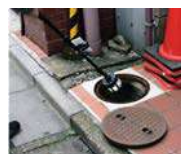
入口の狭いマンホールのタテ穴、ヨコ穴の状況確認
