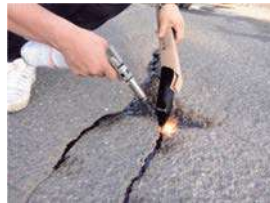
バーナーでの密着作業 (画像はクイックスティック使用時)
